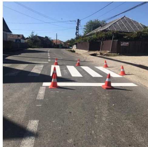
Lucrări pentru execuție marcaje
