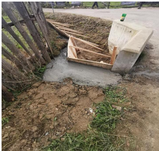
Lucrări de executare rigole
